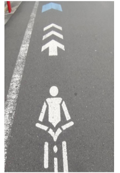
自転車の通行位置と方向を明示する矢羽根型道路標示
