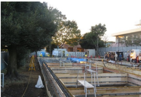
向井公園では、保育所の本工事を着工
