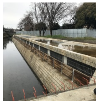
◆調節池の取水口と越流堤(右写真) ◆直径60m、深さ27mの調節池内部(上写真)
