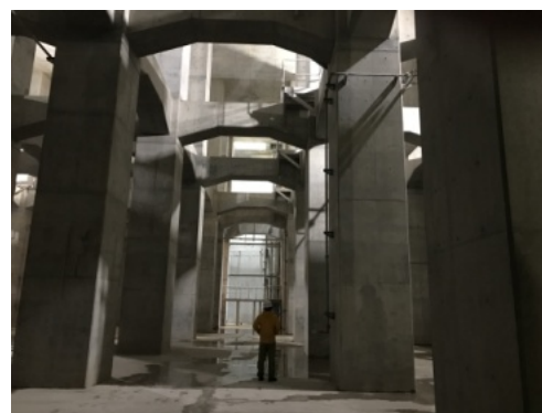
◆調節池の取水口と越流堤(右写真) ◆直径60m、深さ27mの調節池内部(上写真)
